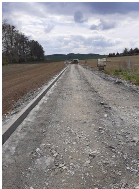
Komunikace k ČOV
